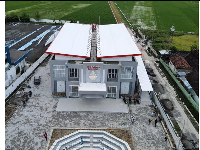
Penampakan dari atas Gedung Layanan Perpustakaan Umum Sukoharjo yang sedang dibangun
